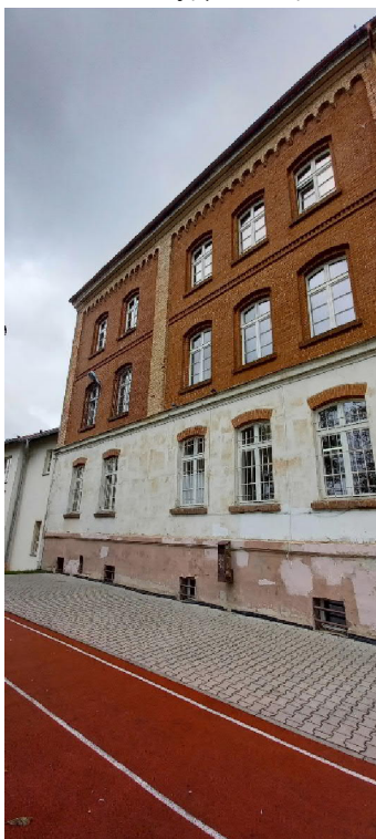
Widoczne ubytki w tynku na elewacjach w strefie cokołowej i przyziemia, drzwi wejściowe do renowacji
