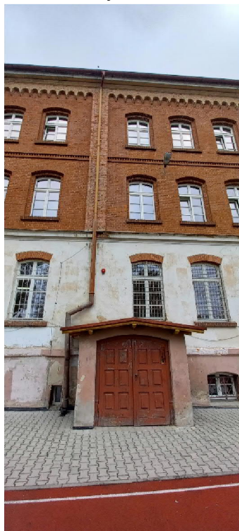
Widoczne ubytki w tynku na elewacjach w strefie cokołowej i przyziemia, drzwi wejściowe do renowacji
