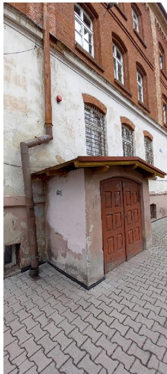
Widoczne ubytki w tynku na elewacjach w strefie cokołowej i przyziemia, drzwi wejściowe do renowacji
