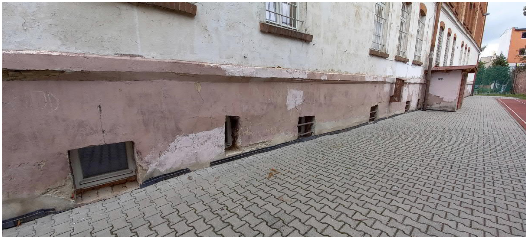
Uszkodzona część cokołowa budynku
