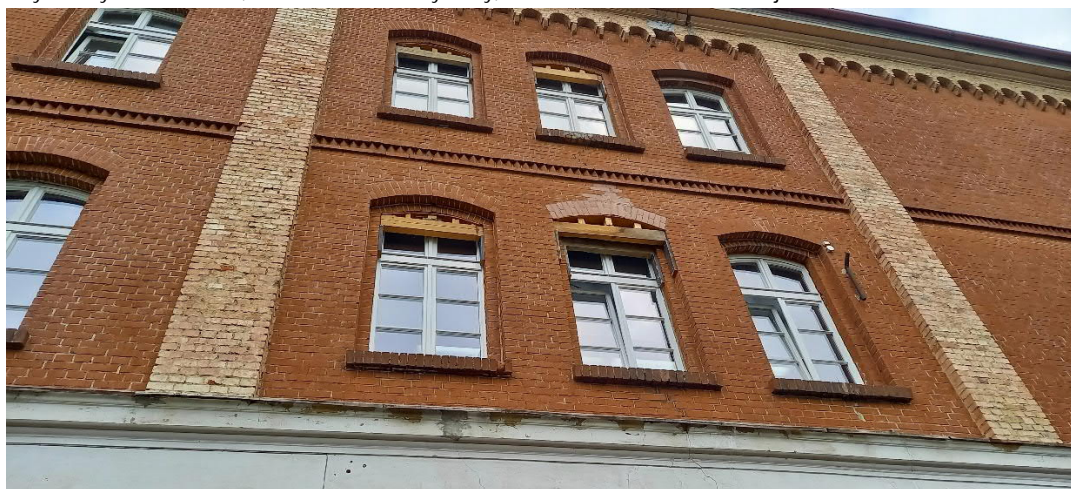
Uszkodzone nadproża na elewacji południowej
