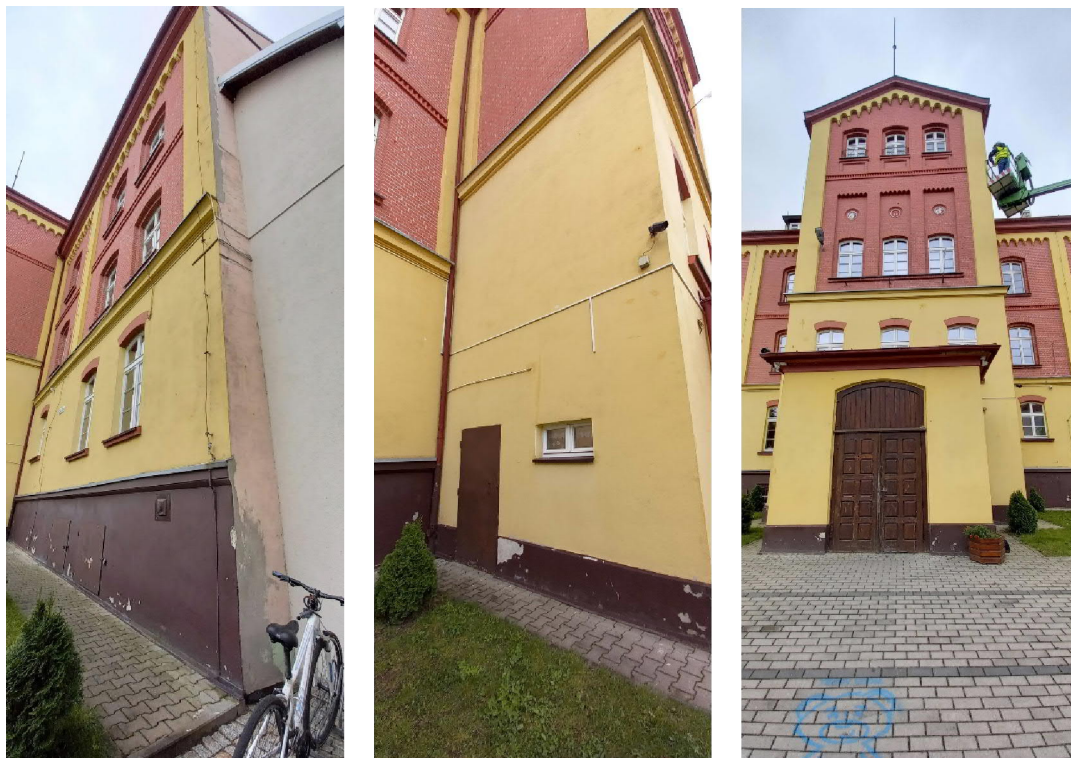
Ubytki w tynku na cokole, drzwi stalowe do wymiary, drzwi drewniane do renowacji
